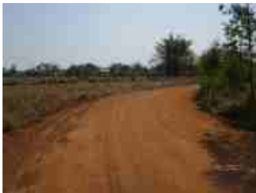
รูปที่ 2-2 ถนนลูกรังสำหรับการขนส่งของโครงการ อยู่ในสภาพที่ตีเหมาะแก่การคมนาคม
