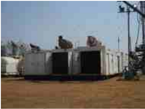
รูปที่ 2-6 การติดตั้งเครื่องกำเนิดไฟฟ้าในตู้คอนเทนเนอร์ ที่มีวัสดุดูดซับเสียงปิดล้อมโดยรอบ
