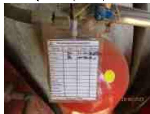
รูปที่ 2-27 การติดตามตรวจสอบสภาพของอุปกรณ์ ดับเพลิง
