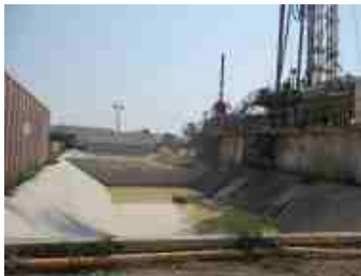
รูปที่ 2-8 บ่อคอนกรีต สำหรับรองรับของเสียที่เกิดจากการเจาะ
