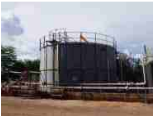
รูปที่ 2-48 คันคอนกรีตล้อมรอบถังเก็บน้ำมันดิบและน้ำจากกระบวนการผลิต เพื่อรองรับสำหรับกรณีเกิดเหตุรั่วไหล
