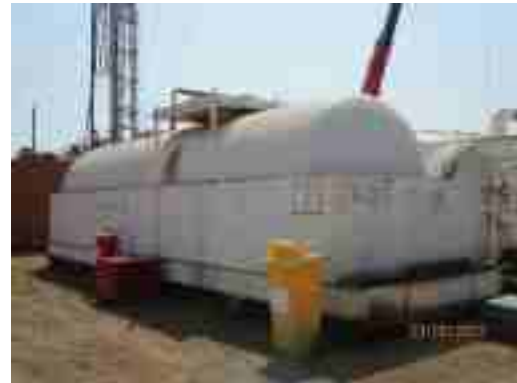
รูปที่ 2-13 ถังเก็บน้ำมันเชื้อเพลิงพร้อมคันกั้น
